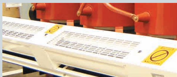
Fig. 7 Aumento de potência com ventiladores radiais
